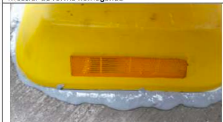
Buena cantidad de pegamento en su parte inferior
