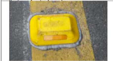
Forma Correcta de Instalación, extiende para todos los bordes del dispositivo.
